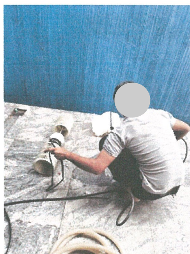
รูปภาพที่ 2.32 การทำความสะอาดเครื่องปรับอากาศ
