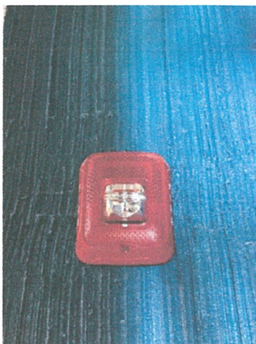
อุปกรณ์แจ้งเตือนแบบเสียงและแสง
