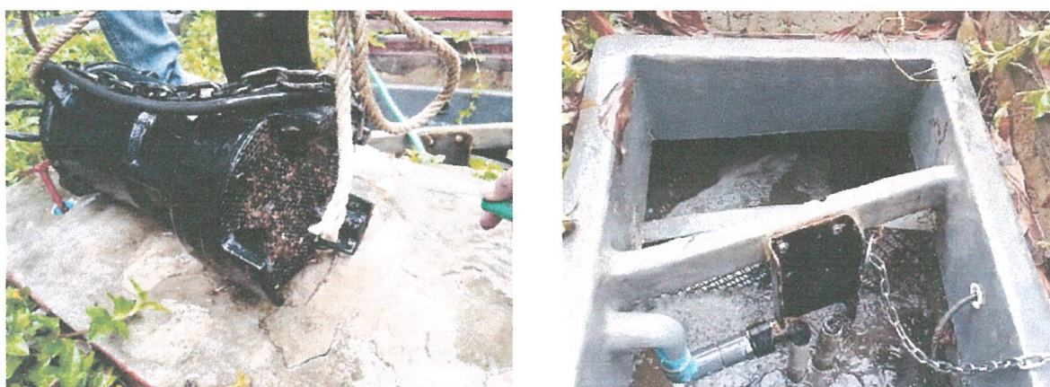
รูปภาพที่ 2.20 การตรวจเช็คระบบบำบัดน้ำเสีย
