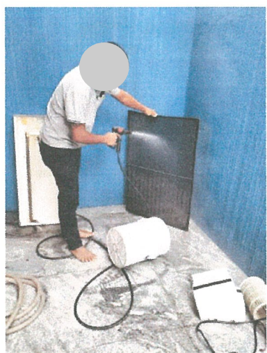
รูปภาพที่ 2.32 การทำความสะอาดเครื่องปรับอากาศ
